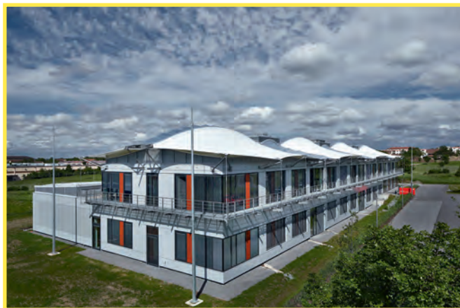
Innovatives Forschungs- und Demonstrationsgebäude des Zentrums für angewandte Energieforschung am Würzburger Hubland. © SSF Ingenieure
