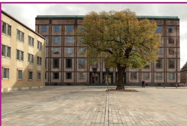
Der sanierte Peterplatz 2011, Foto: Staatliches Bauamt Würzburg
